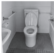
整備された公園のトイレ
