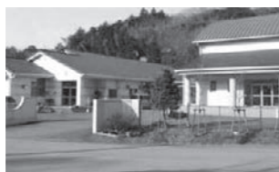
統合で廃校となる野津原西部小学校(平成12年度建築・築17年)
